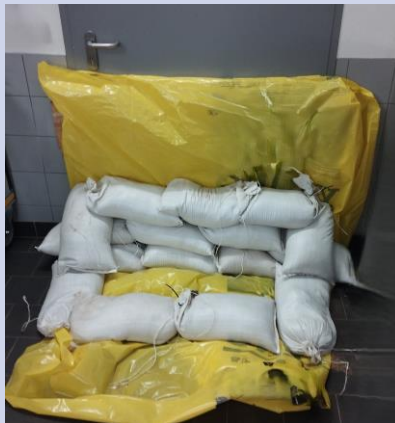
Geschütztes Kellerfenster / Türe
