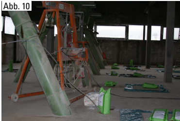
Abb. 11 rechts Brandeinwirkung am Silofuss und an der Aus-tragsschnecke durch das Lagergut im Inneren
